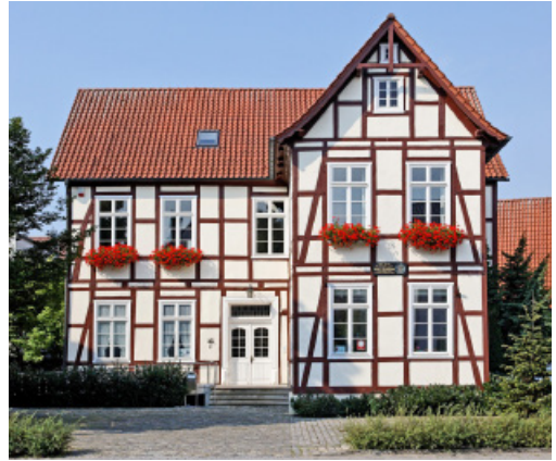
Das 2010 komplett sanierte Zumbusch-Haus. (Foto: Michael Wöstheinrich)
